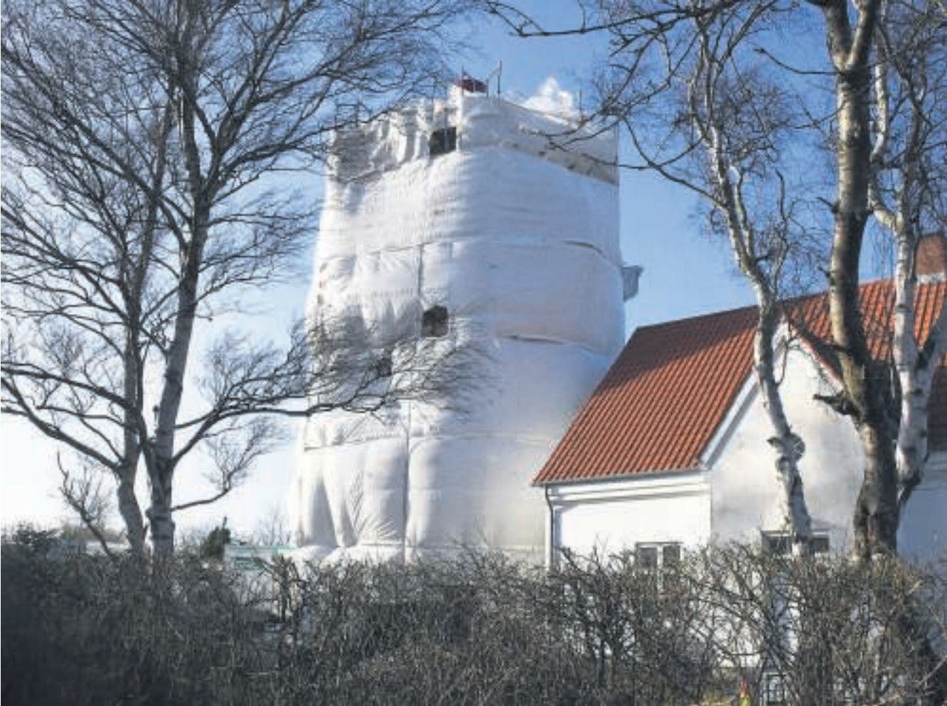
Det skulle have været en kortvarig, overskuelig renovering. Men nu har fyrtårnet på Gedser Odde været skjult bag presenninger og stillads i mere end et år. Nu er der håb forude. Indenfor de næste to uger slutter det uventet store arbejde - og tårnet får overfrakken af. Arkivfoto: Anders Knudsen
